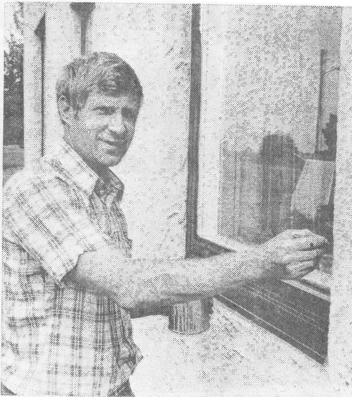
Inge Wernersson arbetar själv mycket med renoveringen av den nya bostaden i Luttra. Här målar han fönsterkarmar.
