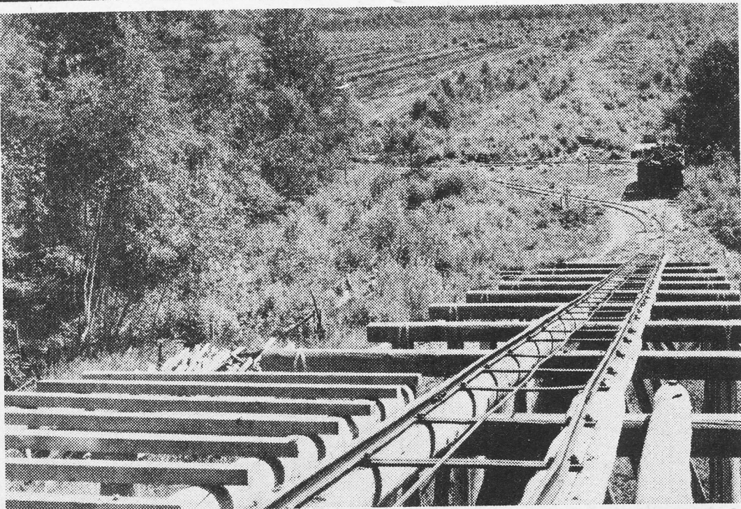
Utsikt över mossen från torvströfabrikens övervåning. Längre bort skimtar områden för torvtäkt.
