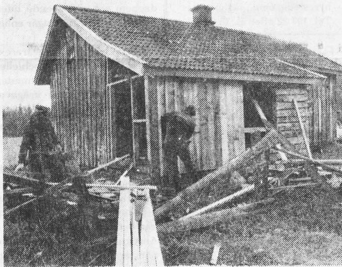
Renovering av Gubbaruts stuga, liten, oansenlig och aldrig målad.
