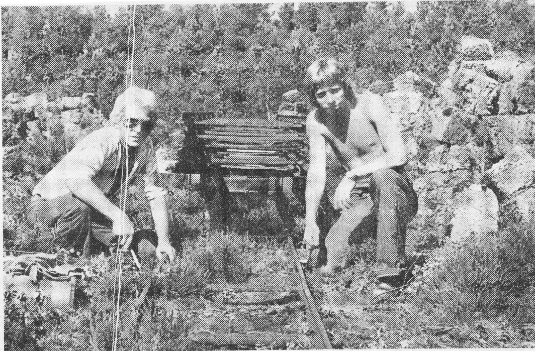
Ingemar Jansson, och Jan Gunnarsson lägger räls för en ny bansträckning. Runt banan finns stukor med torkad torv som skall transporteras in.
