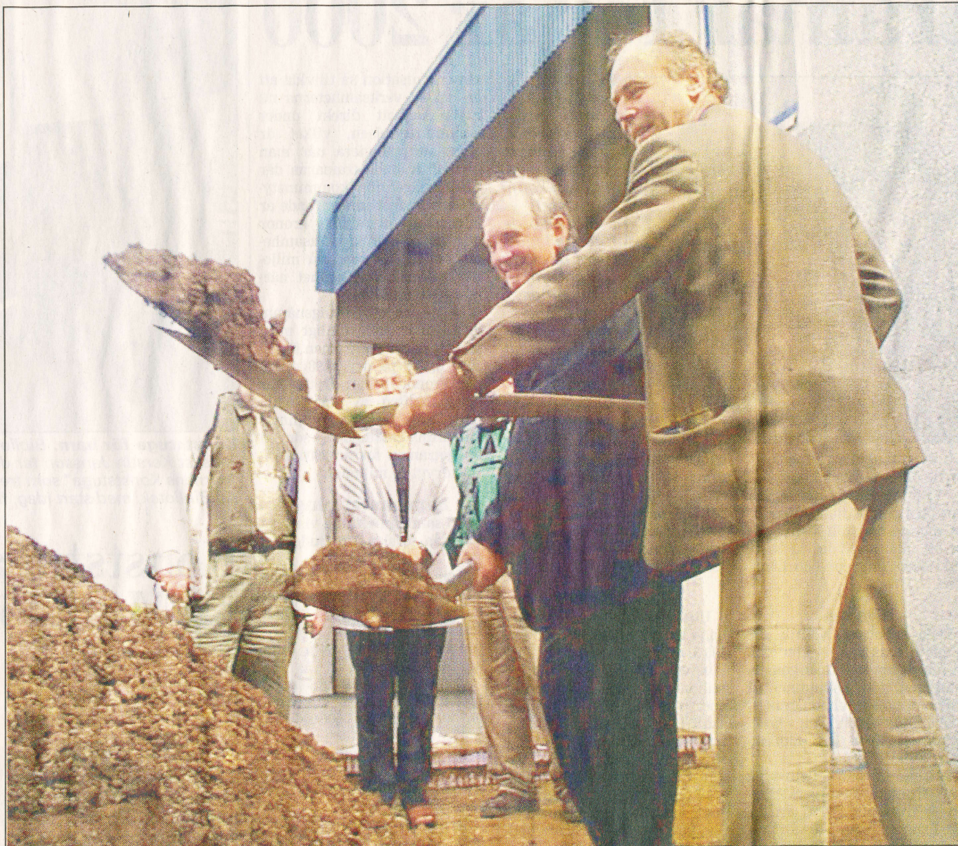
Vanar inne. Henry Jarlsson och Anders Svensson, vd respektive fastighetschef på Kinnarps har tagit en hel del spadtag framför kameran i år. Ett nytt ställverk är senaste projektet. Bild: HÅKAN JOHANSSON
