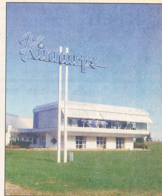
Byggsdes 1988. Granstrands fabrik stod färdigt 1988, en tid efter det att Kinnarps tagit över som ägare av fabriken. Företaget, på bilden bara kontorsdelen är beläget vid E4 i utkanten av Skillingaryd.
